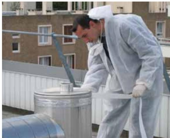
**Figure 53 : Pose d'une bande adhésive au niveau du té-souche suite à opération de nettoyage**
