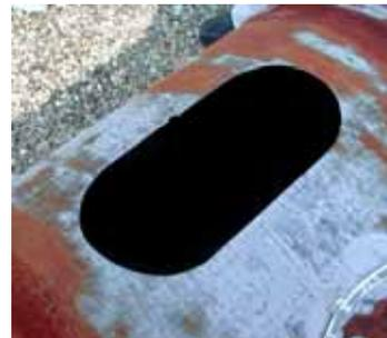
Figure 57 : Découpe de la trappe de visite sur un conduit spiralé (à gauche) et non spiralé (à droite).
