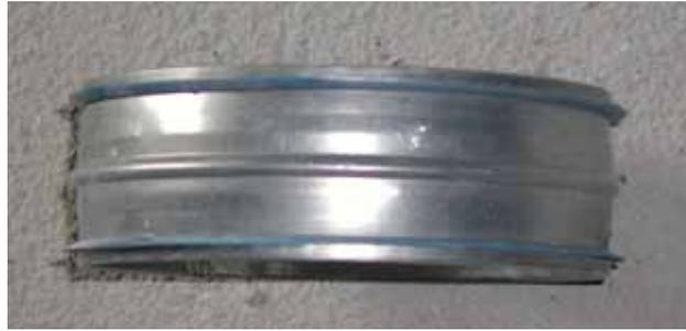
Figure 43 : Utilisation d'un raccord mâle à joints pour le raccordement entre deux conduits
