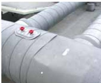
Figure 56 : Exemple d'une trappe de visite non adaptée à la dimension du conduit
