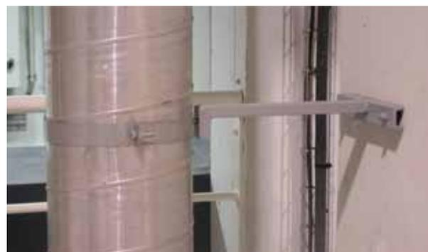
Figure 46 : Illustration du supportage d'un réseau collecteur vertical
