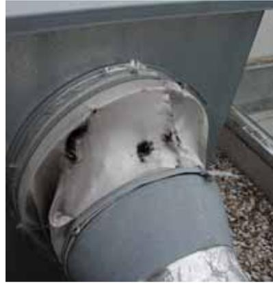
Figure 48 : Exemples de raccords entre le caisson d'extraction et le conduit aérodynamique. Apparence correcte à gauche ; machette fissurée raccordant deux sections différentes à droite (solution à proscrire)
