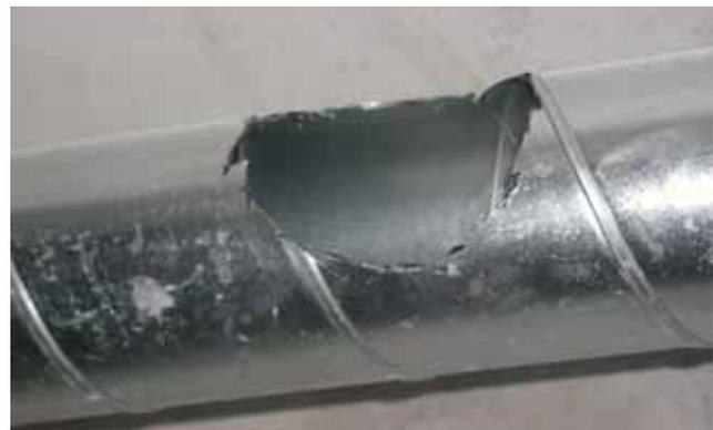
**Figure 42 : Exemple de raccord par piquage d'apparence correcte (à gauche), peu soigné (à droite)**
