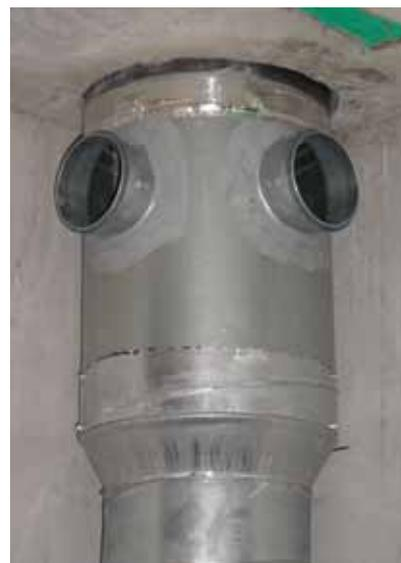
**Figure 39 : Exemples de raccords d'étage avec joints préfabriqués**
