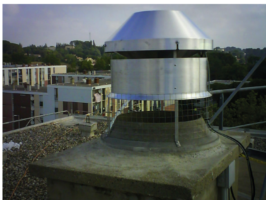
Figure 31 : Extracteur avec conservation de la dalle existante en pose directe et sur une pièce de forme
