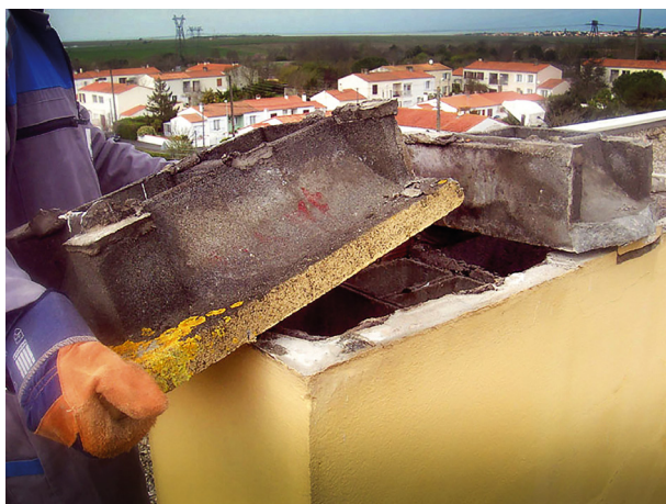
Figure 20 : Retrait de la dalle et de la coiffe existantes
