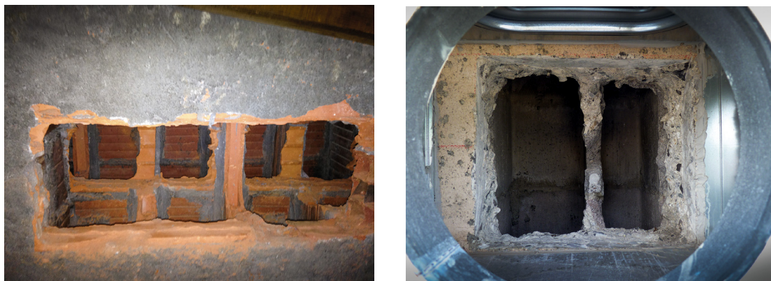
Figure 22 : Ouverture latérale d'une souche avant installation d'un plenum en piquage
