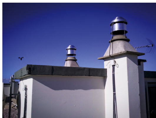
Figure 31 : Extracteur avec conservation de la dalle existante en pose directe et sur une pièce de forme
