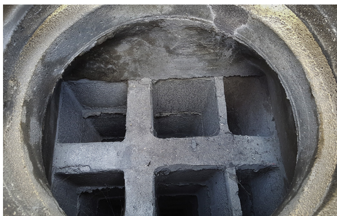
Figure 21 : Coiffe existante retirée et dalle conservée
