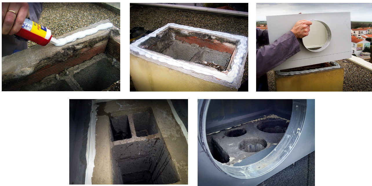
Figure 23 : Mise en place d'un plenum de recouvrement sur une souche (exemples avec dalle non conservée)
